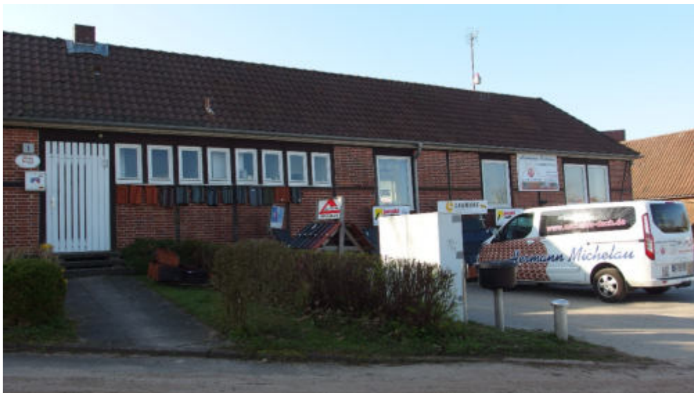
Abb. 2: Blick nach Südwesten auf das Bürogebäude (Nr. 1 im Ergebnisplan).
