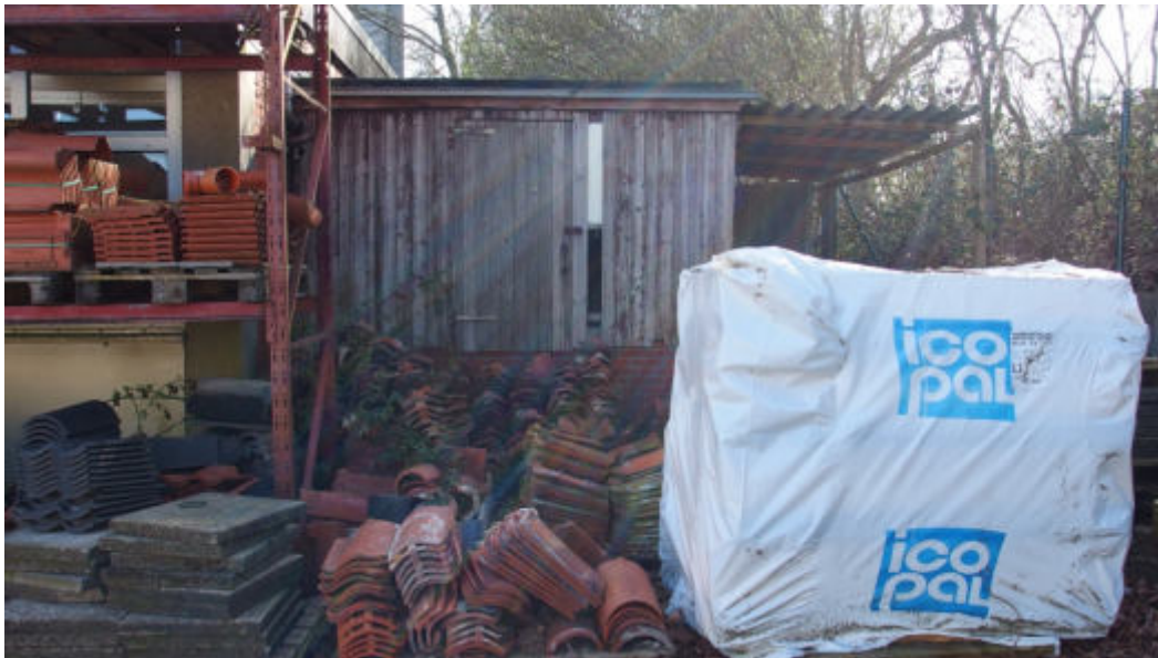
Abb. 7: Blick nach Osten auf den Schuppen, in dem der oberirdische Heizöltank steht
