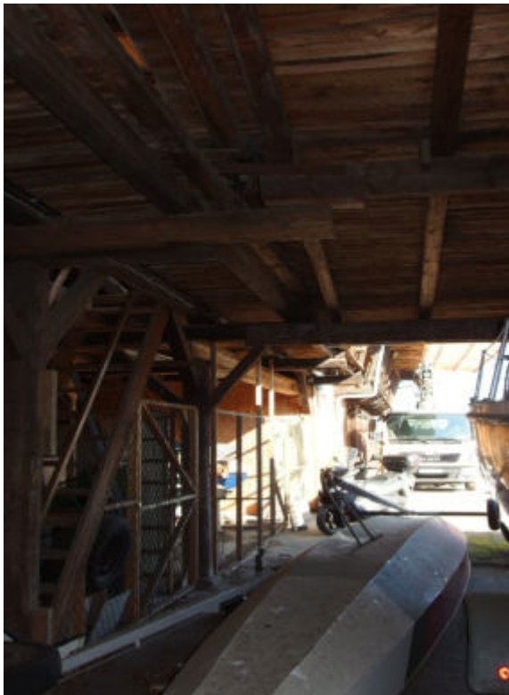
Abb. 4: Blick nach Norden unter der offenen ehemaligen Abbundhalle entlang.
